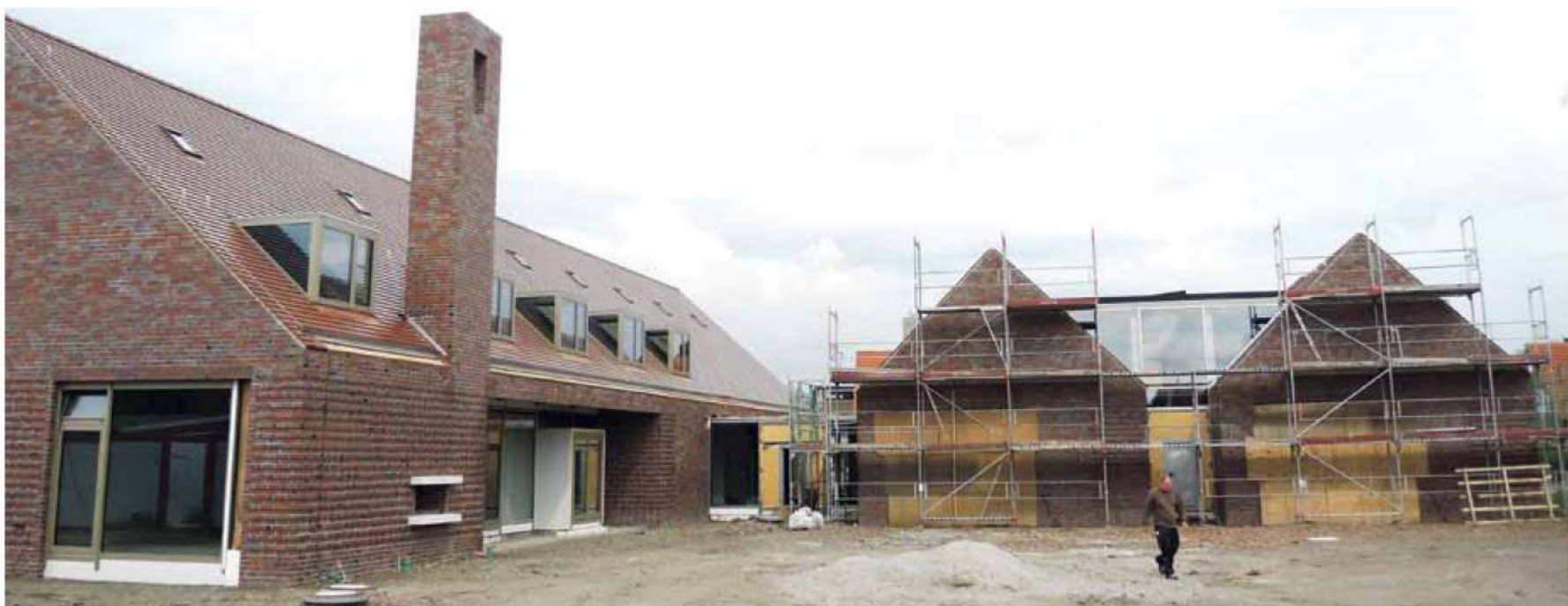
Haus Meedland: Zwei Häuser sind im Rohbau fertig.
